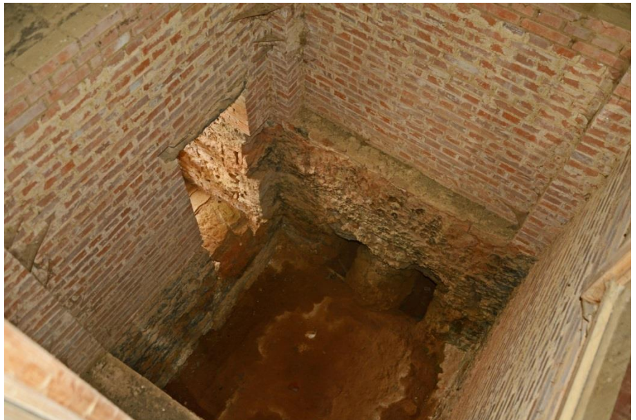
Abb. 15: Blick in den Brennofen von oben – das untere Drittel in Sandstein-Bruchstein, darüber die Backsteinauskleidung. Der Ofen wurde vor dem Brennen oben und in der Beschickungsöffnung (durchleuchtet in der linken Wand) verschlossen.
