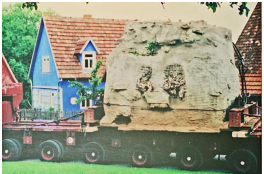
Abb. 16: Der in einer Spritzbetonhülle ‚verpackte‘ Brennofen auf dem Weg zu seinem neuen Standort im Freilandmuseum vor dem auffälligen, weil tiefblau gestrichenen Schäferhaus (Haus 4 in der Baugruppe Odenwald).
