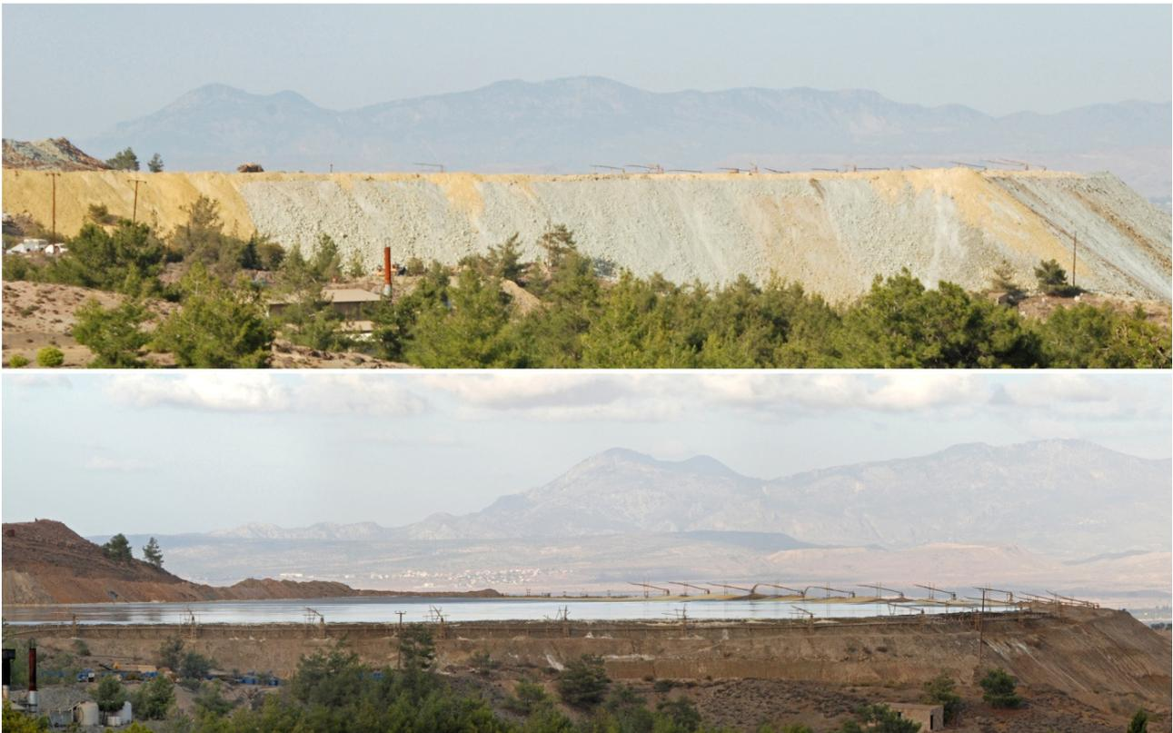
Abb. 39: Zwei Aufnahmen der großen Halde im SO des Minengeländes vor der Pentadaktylos-Kulisse (leider wegen des Straßenneubaus aus leicht unterschiedlicher Position), unten Oktober 2009, oben April 2012: Die Halde ist erheblich gewachsen und zeigt frisch aufgeschüttetes gemahlenes Kupfererz, die Sprinklerkanonen für den Bioleaching-Prozess – im 2009-er Bild gut zu sehen – sind mitgewandert (auch oben auf der Haldenkante von 2012 montiert)
