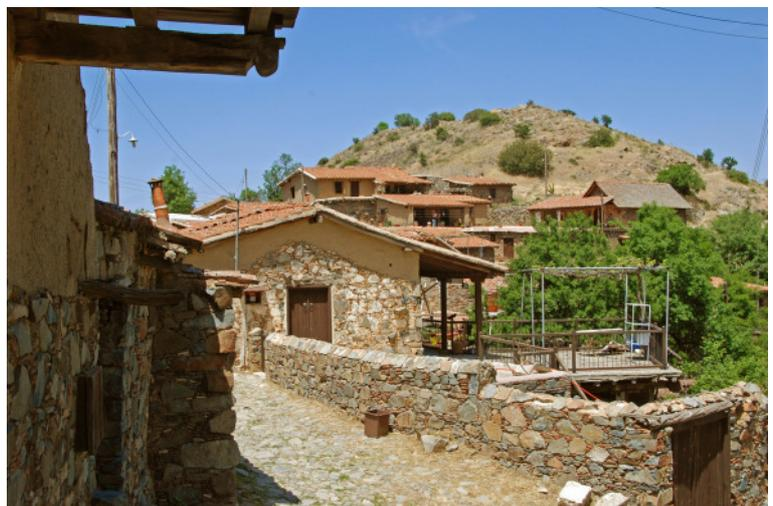
Abb. 46: Gasse in das historische Fikardou mit den typischen Grundmauerkonstruktionen seiner Häuser, auf denen sich Lehmaufbauten mit Terrassen und Veranden erheben.
