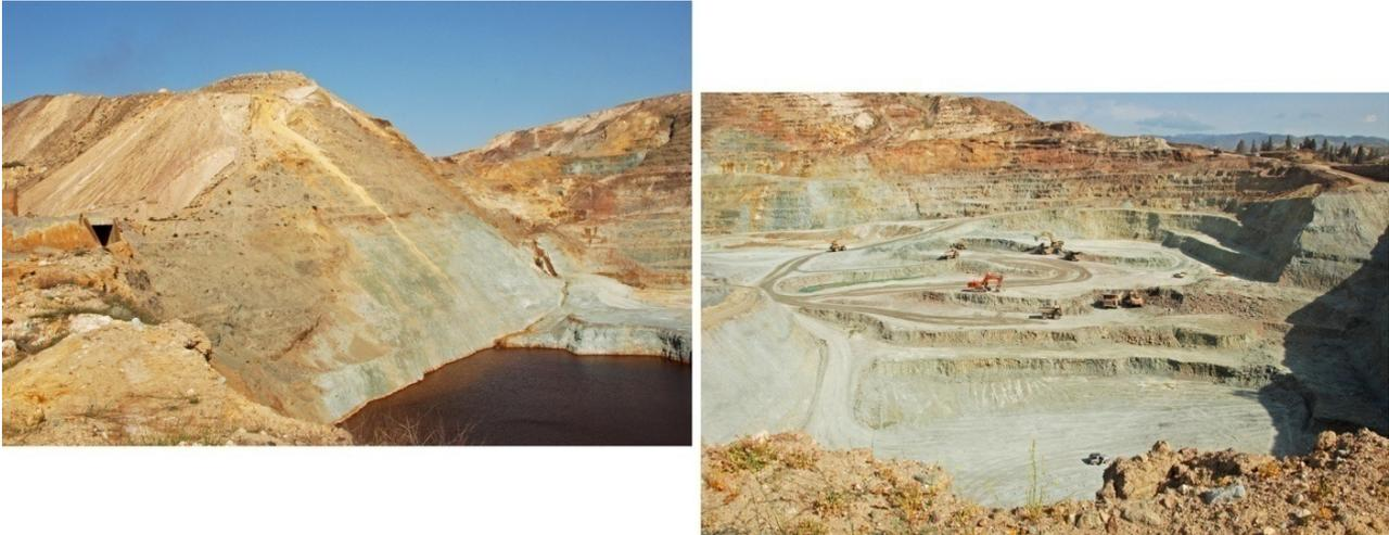
*Abb. 38: nördlicher Bereich der Skouriotissa-Mine – links der vor zwei Jahren noch aktive Abbaubereich, inzwischen mit einer Eisensulfat-gesättigten rotbraunen Brühe vollgelaufen. Aktuell (April 2012) findet der Abbau, vom links gezeigten Bereich getrennt durch einen Damm, daneben statt und schreitet auf die Umfahungsstraße zu (rechtes Bild)*
