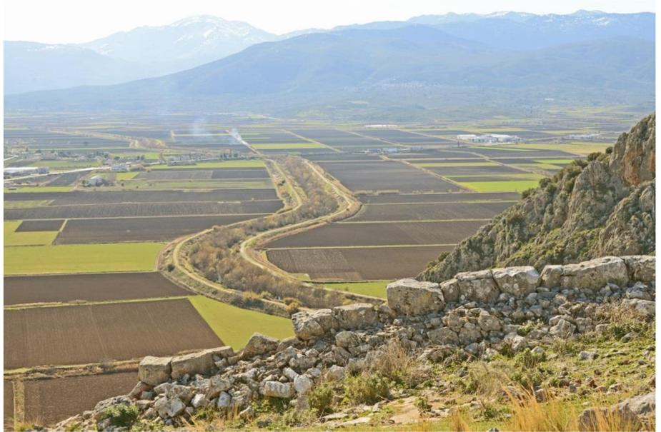
**Abb. 14:** Umlenkung des Kephissos vor Orchomenos in einen Kanal. Die beidseitige Eindeichung soll auch Hochwasserspitzen abfangen. Blick von der Burg über Orchomenos Richtung Süden.
