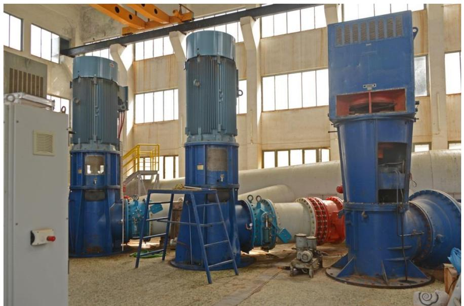
**Abb. 10:** Pumpwerk an den untermeerischen Südwasser-Karstquellen bei Kiveri zur landwirtschaftlichen Bewässerung der Argolis.
