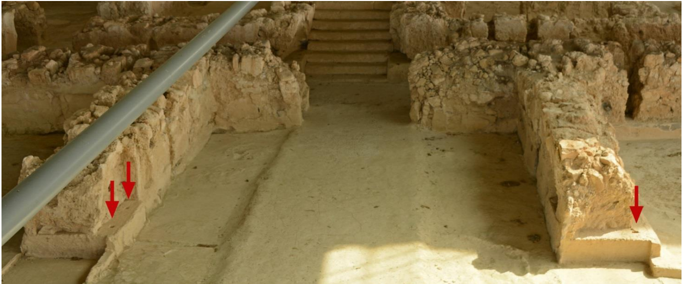
Abb. 11: Die östlichen Wangen der Tordurchgänge im Megaron vom Vorhof (rechts außerhalb) zum Vestibül (Mitte, mit Treppenaufgang hinten) und weiter zum Thronsaal (links außerhalb). Die hier sichtbaren Zapfenlöcher in der Oberfläche der Sockelsteine sind mit Pfeilen markiert.
