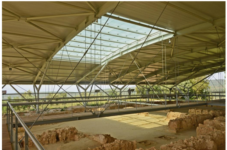
Abb. 3: Teil des neuen Schutzdaches mit Dachfenster über dem zentralen Palastbereich des Megaron und abgehängtem Besuchersteg (Bild 2017-6316).
