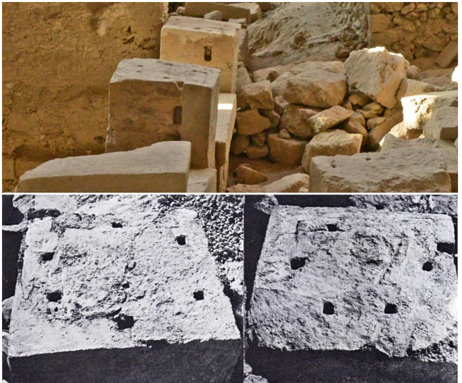
Abb. 10: Zapfenlöcher in den Werksteinen eines Fensterlaibungssockels, SO-Ecke von Xeste 3 im minoischen Thera (oben der Ausschnitt aus Abb. 9, Fotos unten aus: Excavations at Thera V, Tafel 51 b).
