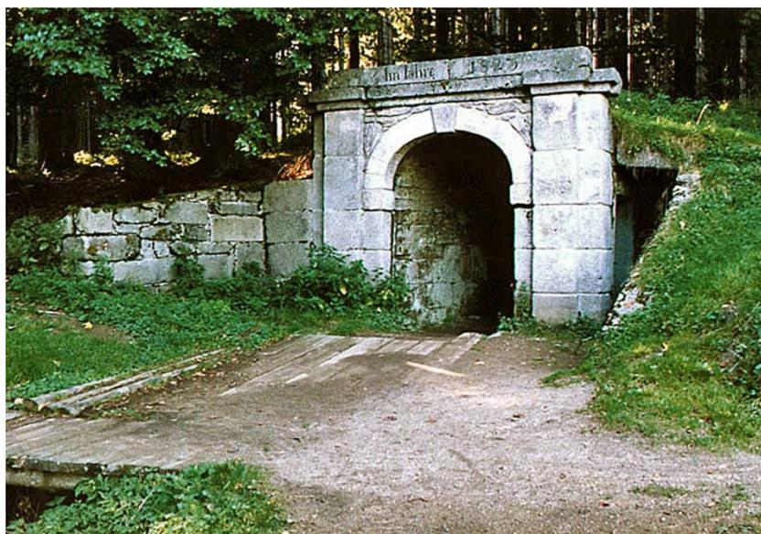
**Abb. 20:** Sorgfältig aus Granit gestaltetes Tunnelportal auf der Trasse des Schwarzenberger Holzschwemmkanals zur. Der hier aufgefahrene Hirschbergen-Tunnel wurde zur Verkürzung einer sehr langen Bergumrundung gebaut.
